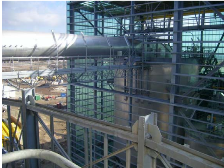
Le traitement des fumées
