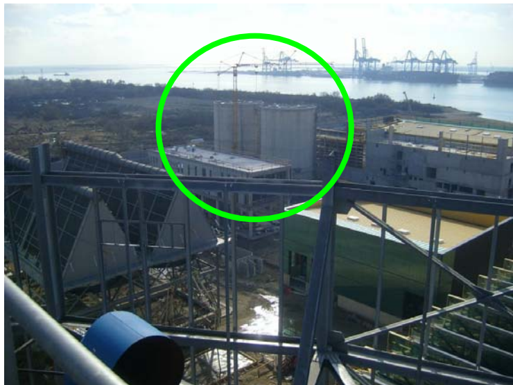
Les digesteurs de méthanisation
