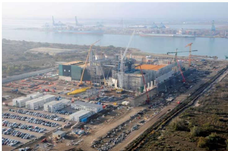
Une vue générale du chantier
