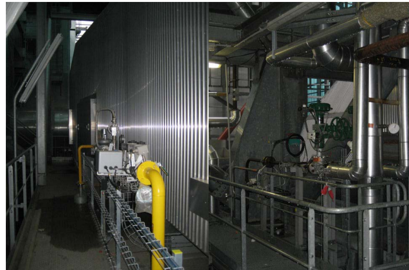
L'intérieur de l'incinérateur
