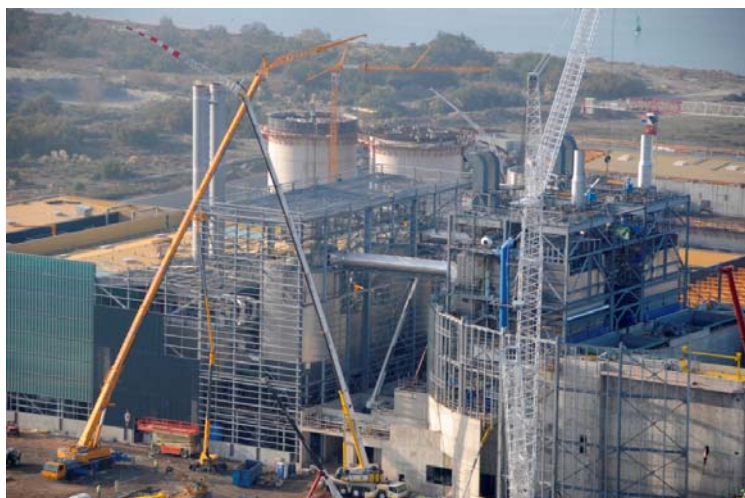
Une vue rapprochée de l'incinérateur
