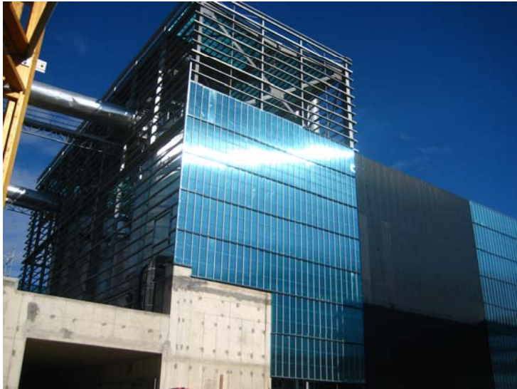
Le traitement des fumées
