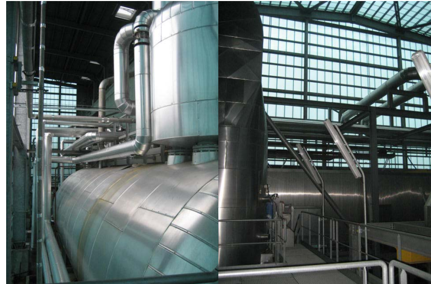
L'intérieur de l'incinérateur à l'été 2008
